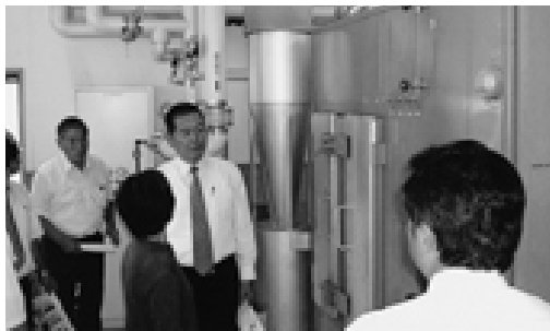
ペレットボイラー
